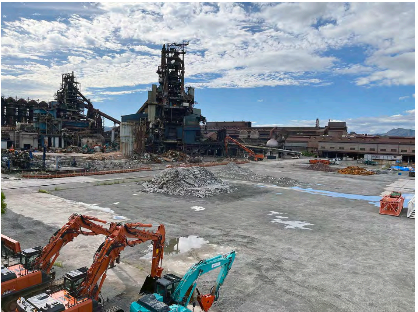
▲日本製鉄「呉」解体状況
